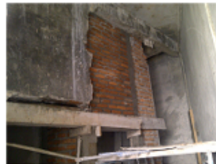
Pek pemasangan batu bata di &#945;&#1090;&#945;&#1109; balok gantung pintu panel
