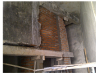
Pek pemasangan batu bata di &#945;&#1090;&#945;&#1109; balok gantung pintu panel
