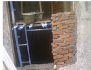
Pek pemasangan batu bata di &#945;&#1090;&#945;&#1109; balok gantung pintu panel
