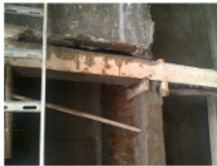
Pek cor balok gantung di atas pintu panel dan toilet
