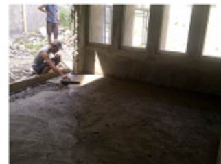
Pek cor level lantai di dining room
