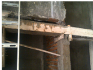
Pek cor balok gantung di atas pintu panel dan toilet
