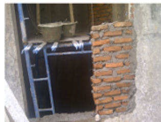
Pek pemasangan batu bata di &#945;&#1090;&#945;&#1109; balok gantung pintu panel
